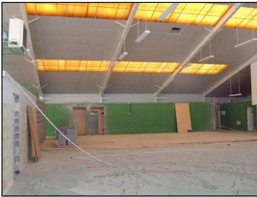
Le chantier du dojo en septembre 2007
